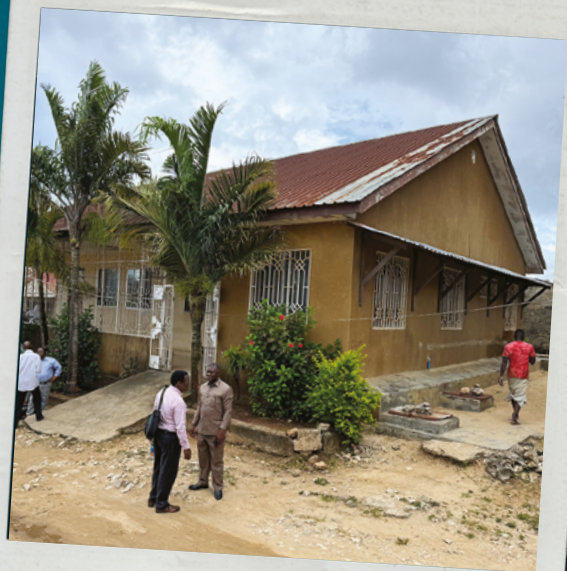
Clínica – Edifício Principal
