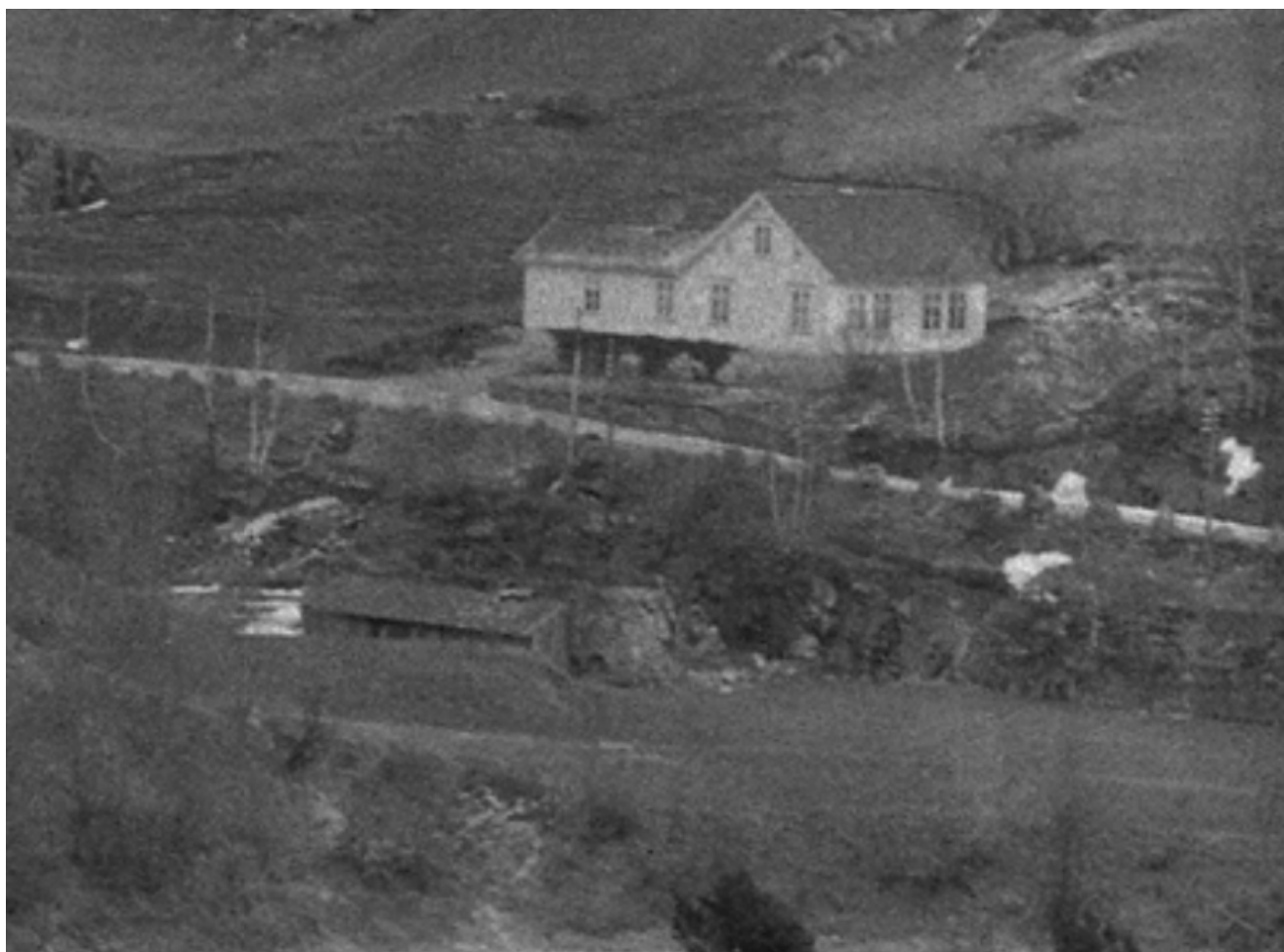
// Kvarstein teglverk ses mellom elva og huset Øvre Sagen. Nedenfor huset ses Tineskleiva som fikk navn etter Tine (Katrine Nygård). Utsnitt av foto fra Norsk Jernbanemuseum. //
