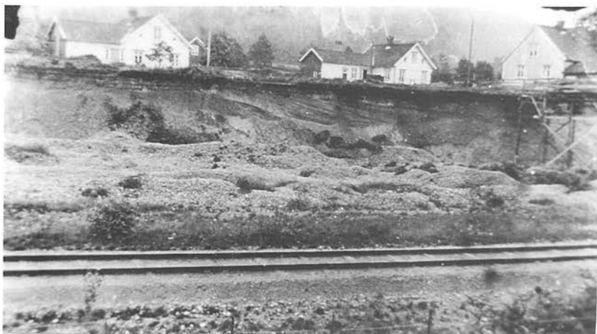
Grustaket ved siden av jernbanen. Helt til høyre skimtes stillaset de kjørte lassene ut på for å tippe grusen ned i jernbanevogner.
